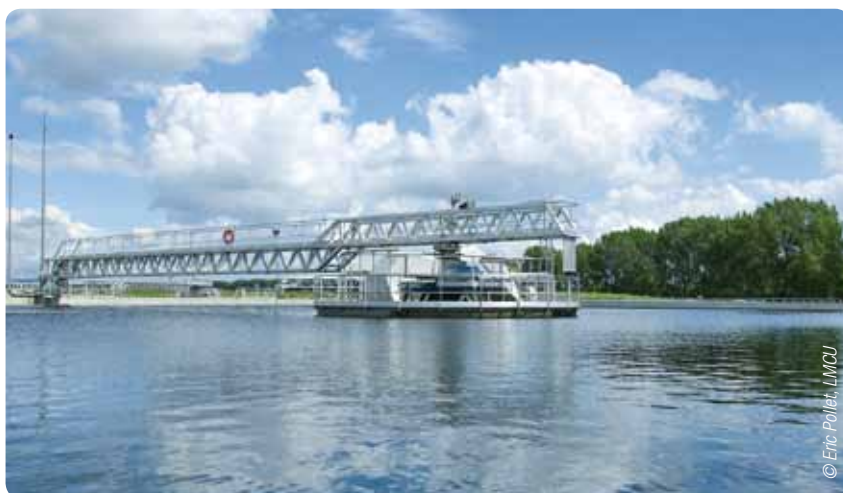
Station d'épuration Grimonpont à Watrelos, Lille
