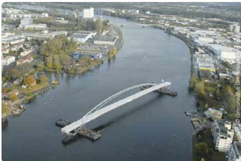
Passerelle en construction entre Huningue (France) et Weil-am-Rhein (Allemagne)
